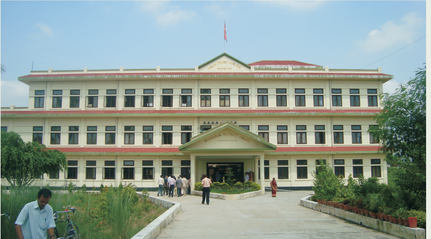
जिल्ला अदालत भवन, धनुषा
