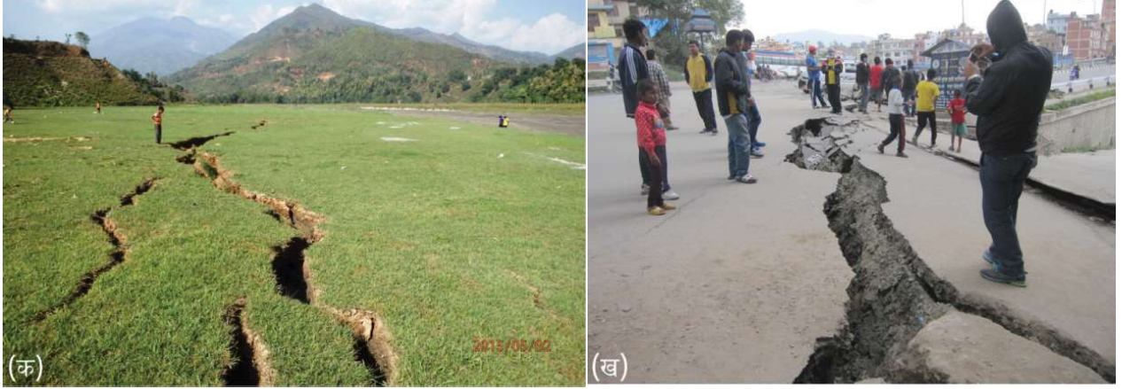
चित्र ३.८ : गोरखा भूकम्पको कारण जमिनमा फाटेका चिराहरू । (क) त्रिशुली जलविद्युत आयोजनाको ड्याम साइट (सौजन्य: Katsuichiro Goda) (ख) कोटेश्वर-सूर्यविनायक सडक खण्ड अन्तर्गत कौशलटारमा जमिन चिरा परेको (सौजन्य: दीपक चम्लागाई) ।
