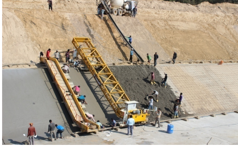
नहरको लाइनिङ निर्माण भईरहेको दृश्य
