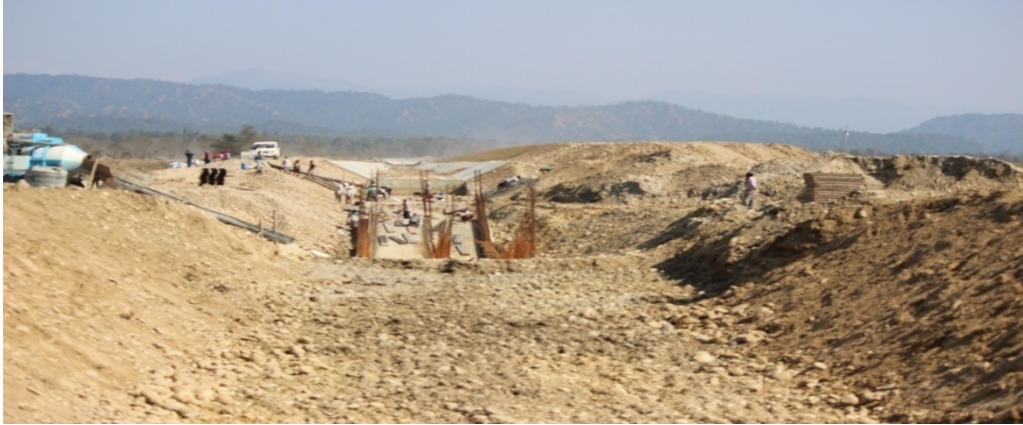
निर्माणाधीन पश्चिम मूल नहर खण्ड
