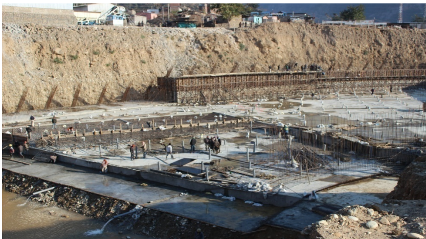
निर्माणाधीन बाँध र रेगुलेटिङ गेट बीचको फोरवे क्षेत्र
