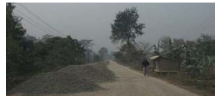
धरान-चतरा सडक खण्डको बेस निर्माण गर्ने तयारी
