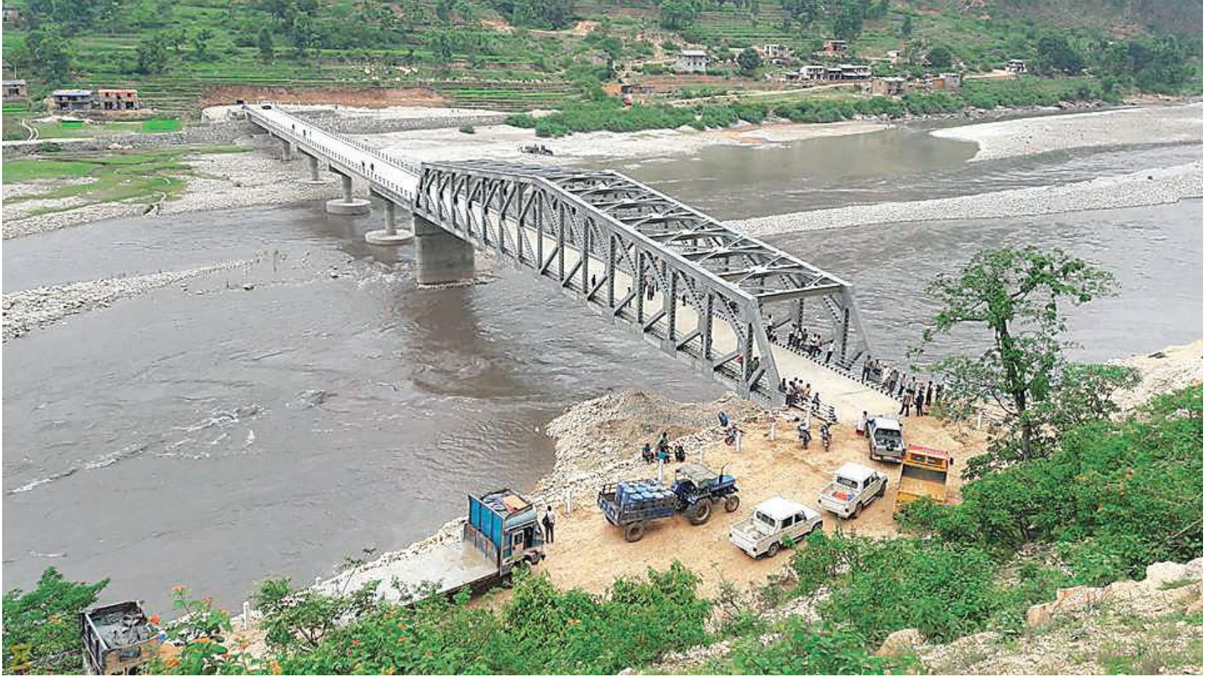
दैलेख र अछाम जिल्लाको सिमानामा पर्ने कर्णाली नदि पुल (१२५ मि. RCC र ७५ मि. steel truss)
