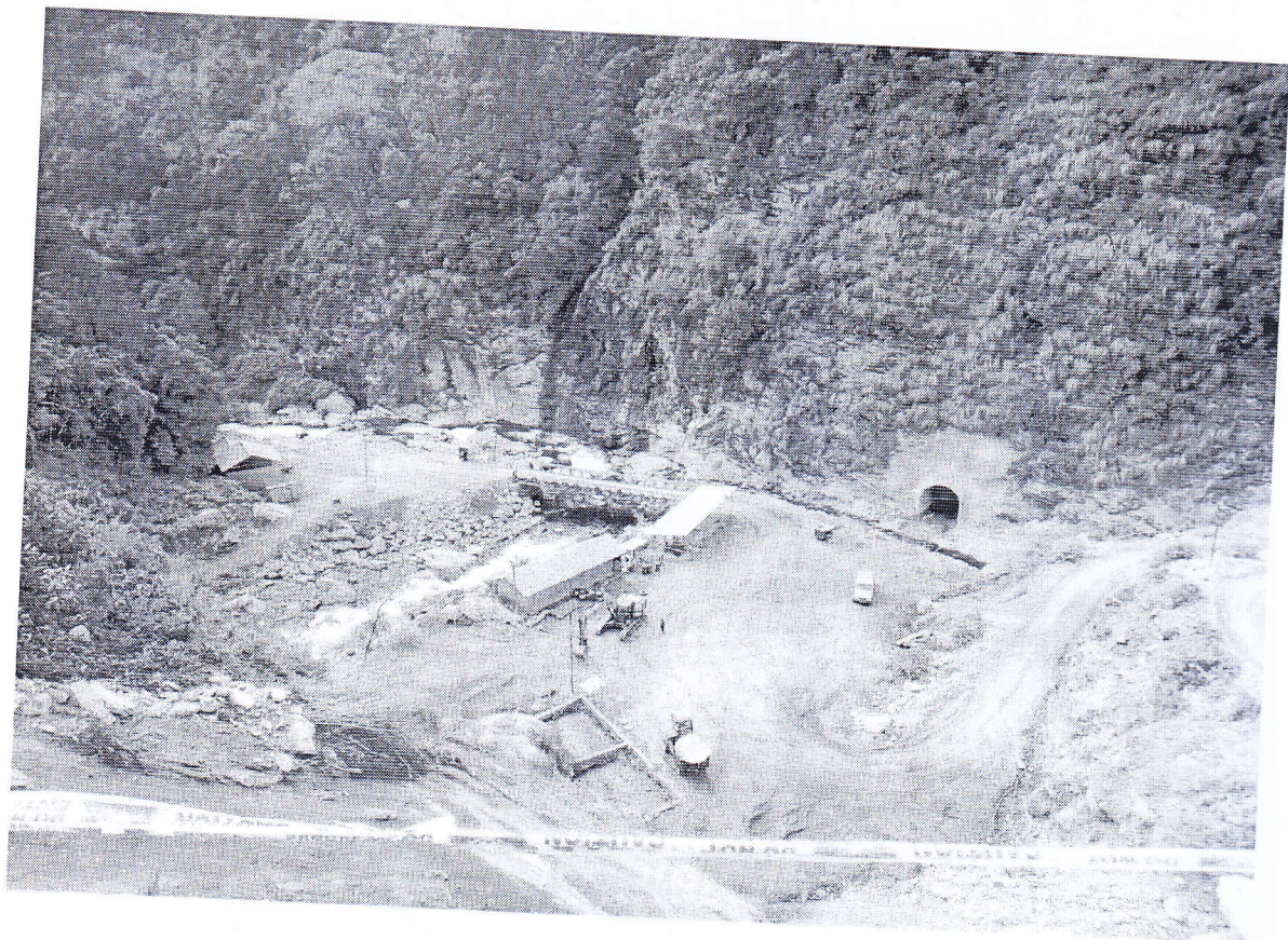
निर्माणधिन मेलम्ची खानेपानी आयोजनाको हेडवर्क्स साईट
