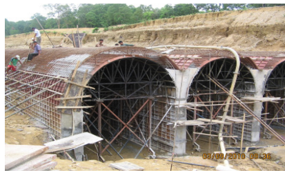
सिक्टा सिंचाईको मूल नहरको निर्माणाधीन सुरुङ्ग संरचना
