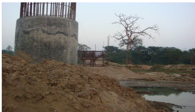
निर्माणाधीन खगेरीखोला पुल
