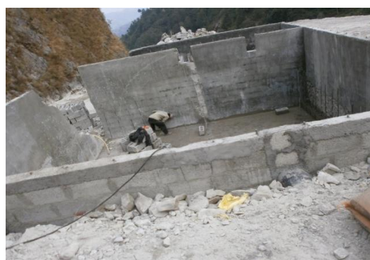
भत्किएको Sedimentation tank वाल
