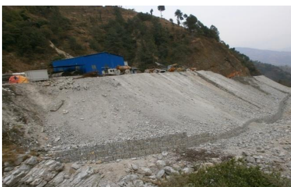
सुरुङ निर्माण क्रममा रसायन मिश्रित ढुङ्गा माटो राख्न बनाइएको क्षेत्र र ओभरपलो भई बाहिर निस्केको अवस्था
