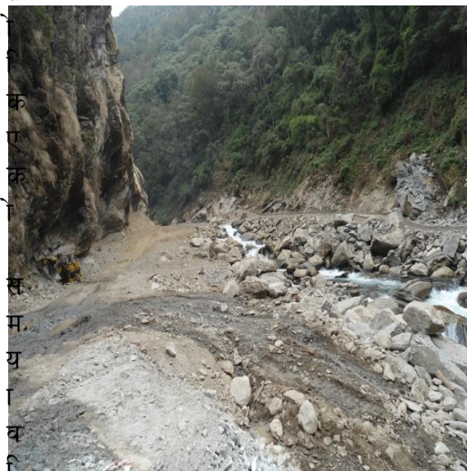
निर्माणाधीन हेडवर्क्स स्थल
