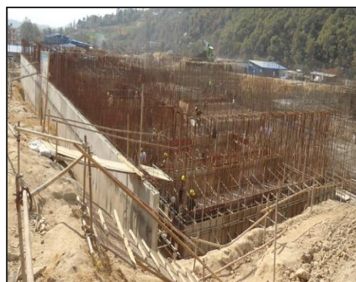
निर्माणाधीन पानी प्रशोधन केन्द्र
