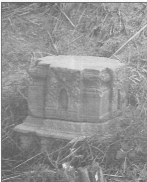
चित्र संख्या ४-क : मल-खाल्होमा रहेको लिच्छविकालीन चैत्य । प्रस्तुत चित्रमा सो चैत्यको दुई तहको आधारपेटी धमिएर रहेको अवस्थामा छ । त्यसमाथि रहने गर्भ भन्ने अर्कोतिर मिल्किएर रहेको अवस्थामा छ । (फोटो : लेखक, लिएको मिति : वैशाख ३१ गते, २०६७)
