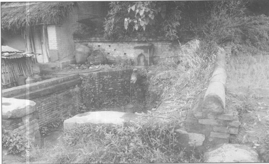
चित्र संख्या १ : भौखेल धारा/झुज छ्यःहिटी, वडा नं ७ । प्रस्तुत चित्रमा दायोपट्टि, सो धाराको पखालको सामुन्ने सडकको किनारमै प्रायः पुरै घसिएर शिर्ष भाग मात्र जमिनबाट माथि उठेको एक प्रस्तर देखिन्छ । यही प्रस्तरफलकमा शिवदेव+अशुवर्माको अभिलेख कुदिएको छ । (फोटो : लेखक, लिएको मिति : असार १० गते, २०७०)
