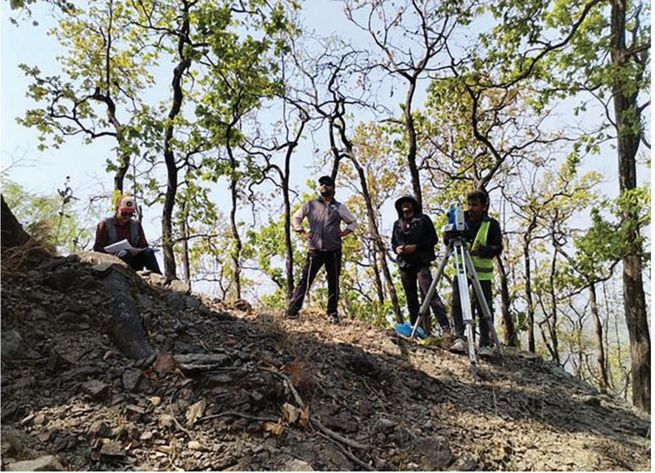
प्रसारण लाइन मार्गमा टावरको जग निर्माणका लागि आवश्यक अस्थायी पहुँच मार्गसम्बन्धी इन्जिनियरिङ सर्वेक्षण हुँदै ।
