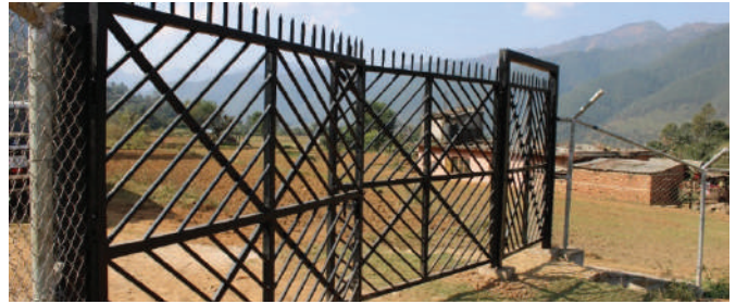
नुवाकोटको बेलकोटगढीमा रातमाटे सबस्टेशन निर्माणका लागि प्राप्त गरेको करिब २०.२७ हेक्टर जग्गा वरिपरि लगाइएको तारबार ।
