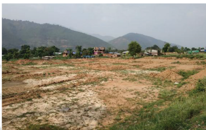
रातमाटे सब-स्टेशन निर्माण स्थल
