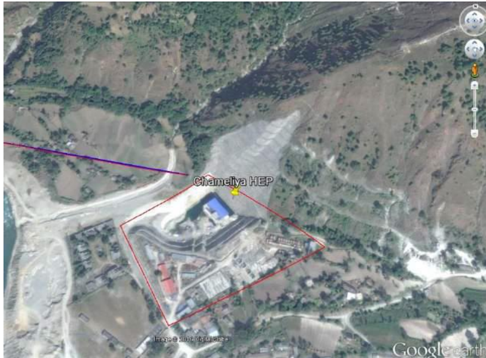
Figure 3.45 Existing Balanch Substation – Latitude 29°41'06.5"N Longitude 80°39'00.5"E
