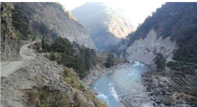
Tamakoshi V Powerhouse Site
