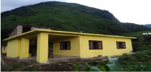
पोस्ट भवन निर्माण, ढोरपाटन
