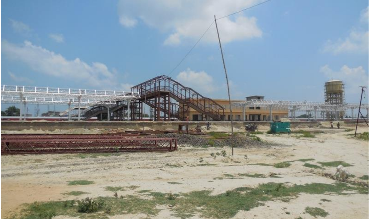
निर्माणाधीन जयनगर स्थित रेलवे स्टेशन भवन
