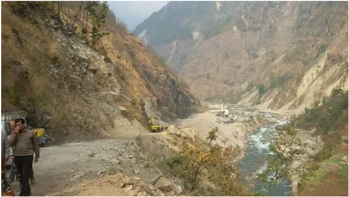
मैलुंग स्यफ्रुवेशी रसुवागढी सडक खण्डको निर्माणाधीन अवस्था
