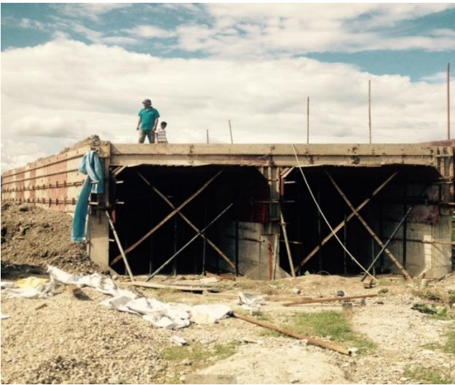
बर्दिबास सिमरा खण्डको निर्माणाधीन box culvert
