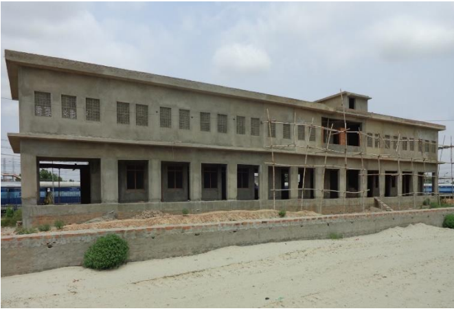
निर्माणाधीन जयनगर स्थित रेल्वे स्टेशन भवन र स्टाफ क्वार्टर
