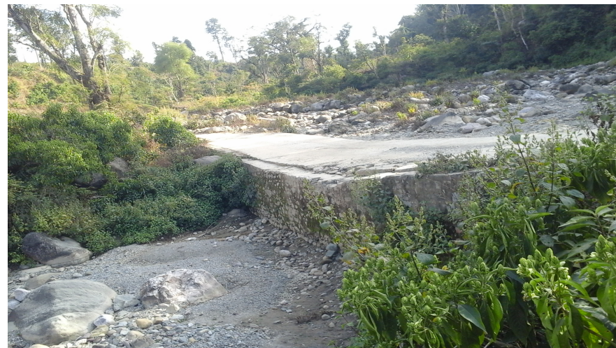
Caption:elevation from downstream
