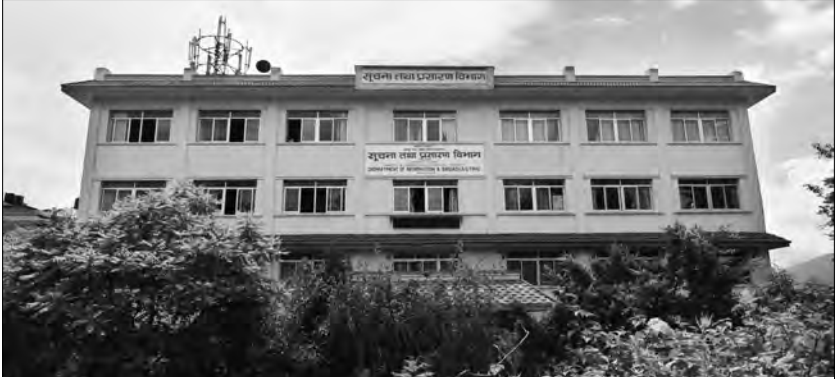
सूचना तथा प्रसारण विभागको भवन, तिलगंगा, काठमाडौँ
