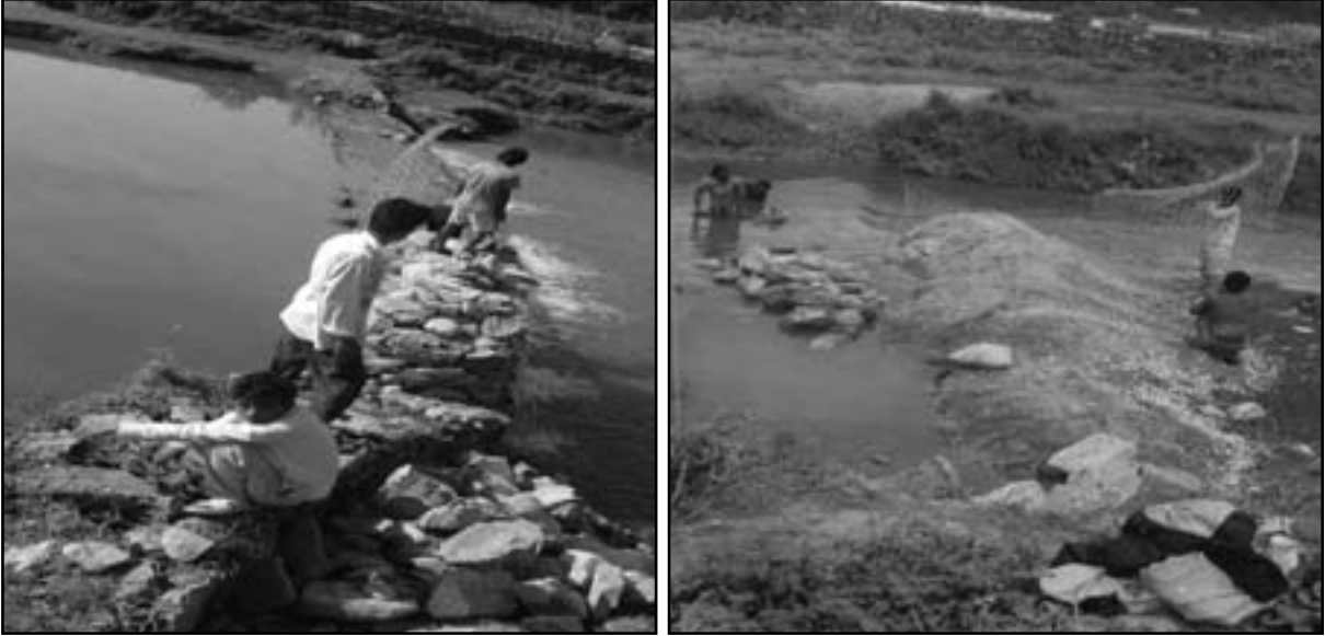
नदीको वहाव नियन्त्रणको लागि वागमती नदीमा चेक ड्याम निर्माण
