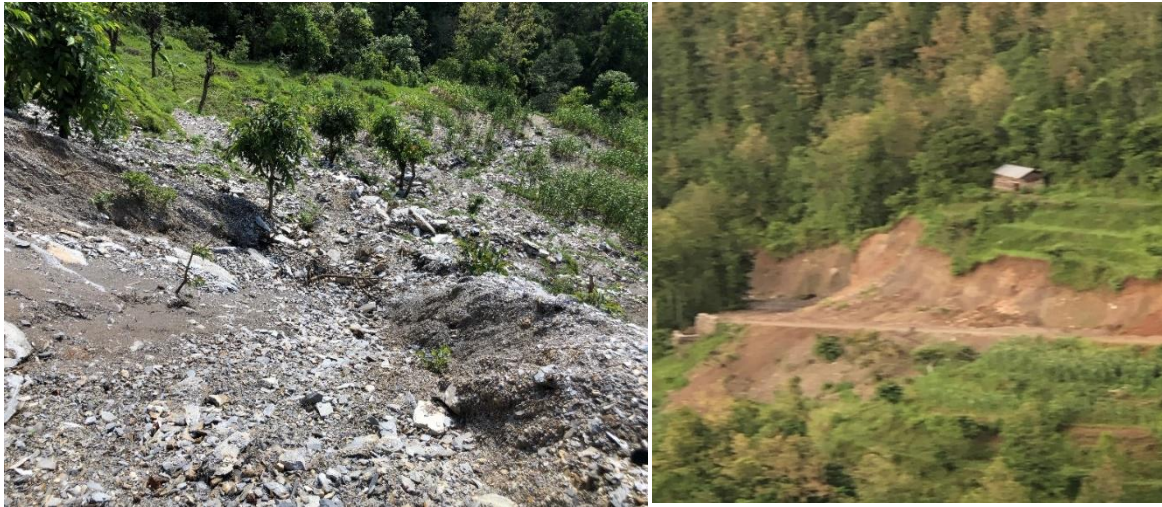
स्रोत : कृष्णबहादुर कुँवर, सडकको भेलले लब्दीको खेत बगर । खन्याथानमा डोजरले गोठखेत कोप्राएर बनाएको भीर कल्भर्ट
