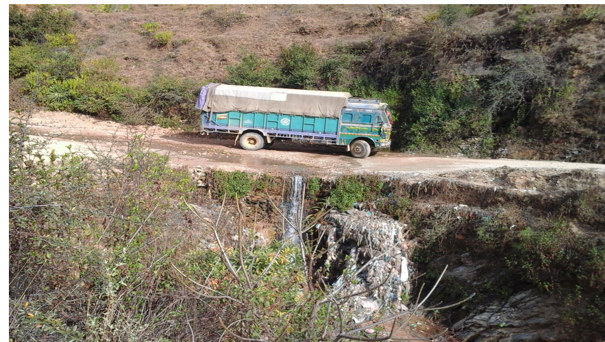
Caption:elevation from downstream
