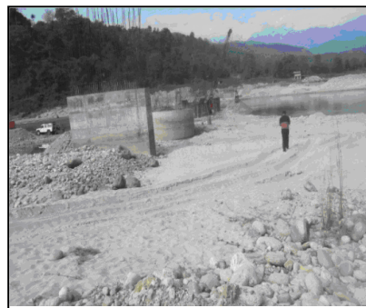
निर्माणाधीन अरुण नदी पुल
