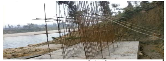
पुरन्धरा सडक खण्डमा पर्ने निर्माणाधीन भेरी पुल
