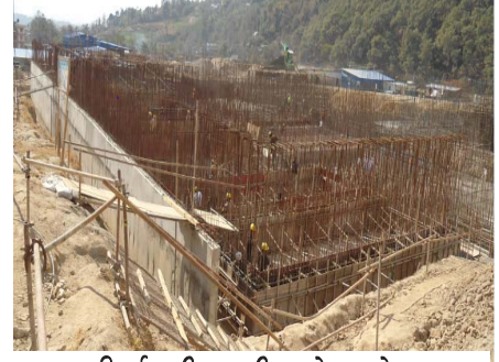
निर्माणाधीन पानी प्रशोधन केन्द्र
