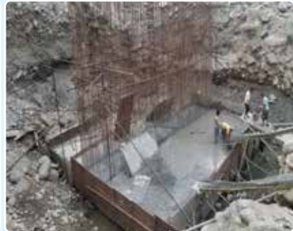
मडमाया पुल, धनकुटाको (निर्माण कार्य सुचारु)
