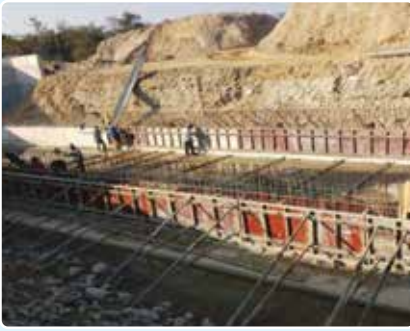
नहर लाइनिङ कार्य टनकपुर मूल नहर
