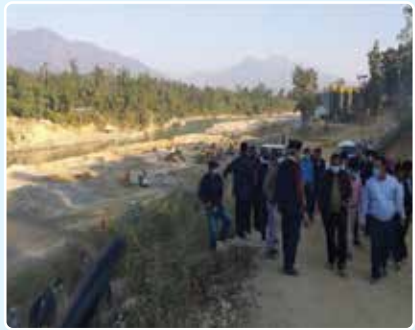
निर्माणाधीन बाँध स्थल
